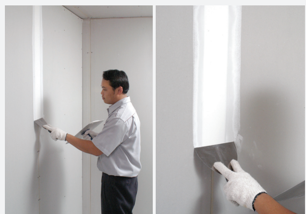
5 ฉาบปิดรอยต่อของแผ่นทุกด้าน 3 เที้ยว ตามมาตรฐานของ トラ้าง ด้วยปูนอิฐซีพลาส120 トラ้าง (ฉาบรอยต่อ) และ เทปผ้ายิปซัมปิดรอยต่อ トラ้าง
