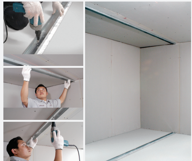
2 ติดตั้งโครงโปรวอลล์ トラ้าง ตัวยู ที่พื้นและที่ฝ้าเพดาน โดยยึดด้วยพุกคอนกรีต ระยะห่างทุกๆ 60 ซม. ปลายโครง ไม่เกิน 5 ซม.
